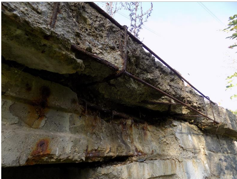
Pravý krajní nosník a rozpdlá římsa nad opěrou OP2
