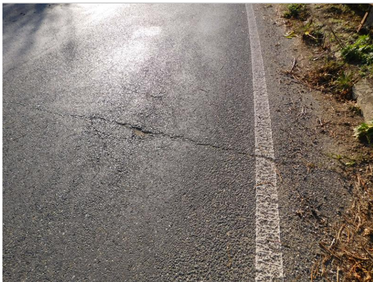
Trhlina ve vozovce za konci říms u opěry OP2
