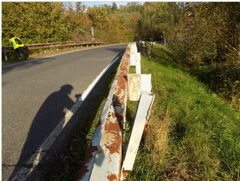
Poškození svodidla vpravo před mostem
