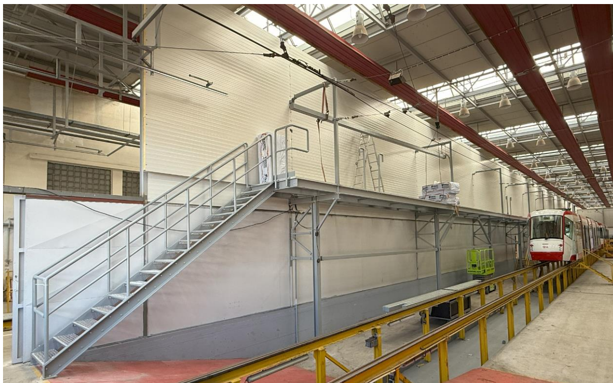
Obrázek 3 - Fotografie nové lávky v průběhu montážních prací (zde bude instalován kolejnicový záchytný systém) - stav k 18.3.2025
