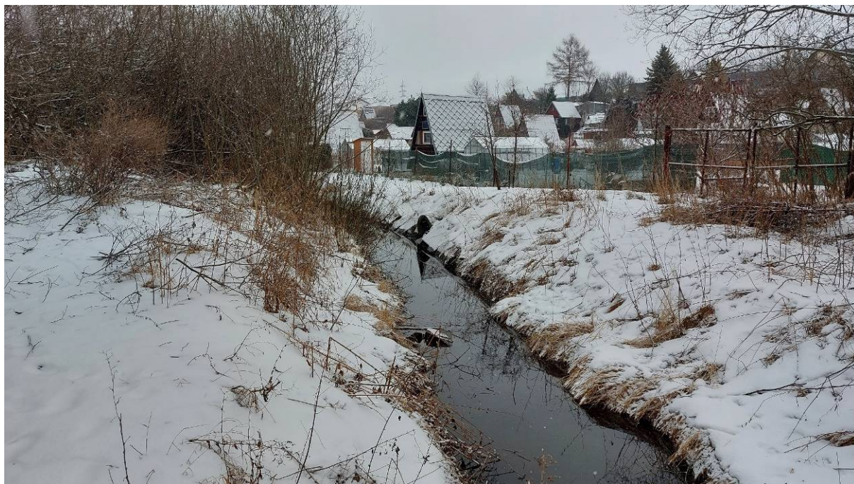
místo řešeného přemostění – pohled proti toku Bukového potoka
