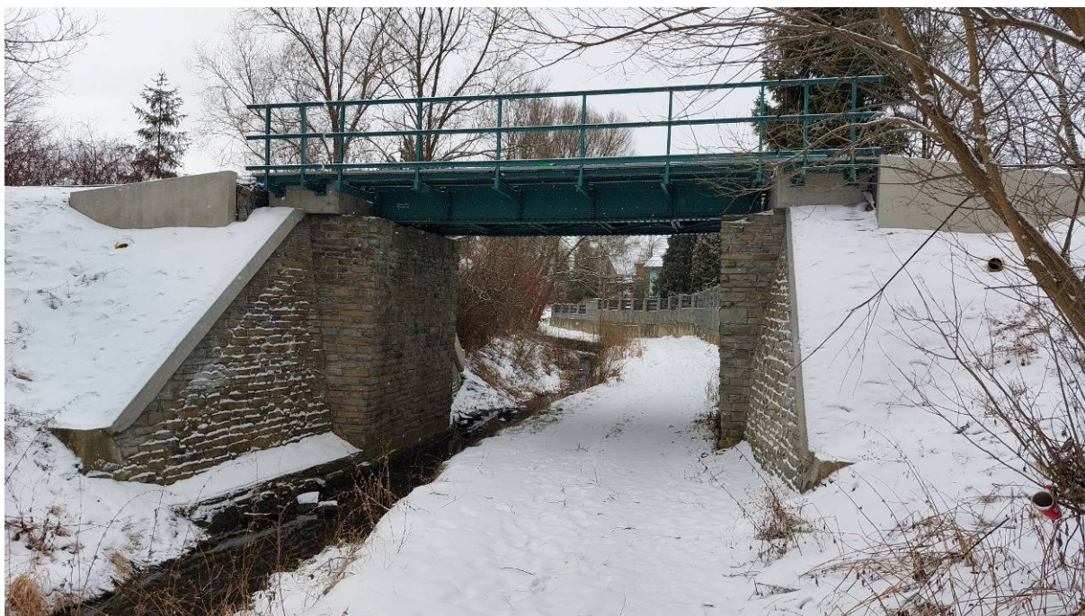
železniční most vedle řešeného přemostění – přístupová trasa dle územního plánu je pod mostem a dále směrem k ul. Kavalcove – vzhledem k prostorovým možnostem maximálně pro pěší a cyklisty
