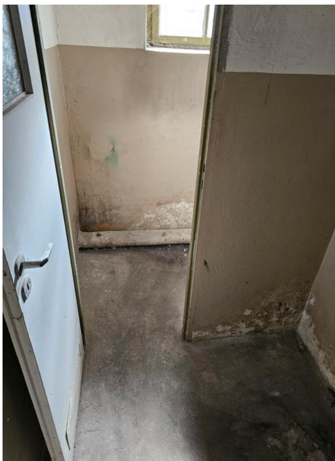
Zdjęcia nr 6. Toaleta w piwnicy
