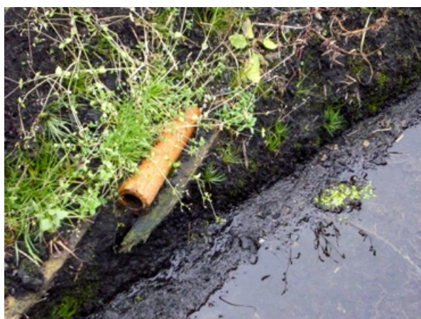
Fot. 52. i Fot. 53. Przypadkowo odkryty wyłot drenarski/rurociąg drenarski na terenie gruntów należących do Przedsiębiorstwa Rolno-Przemysłowego „Agromax”, powiat raciborski (fot. Ł. Borek)
