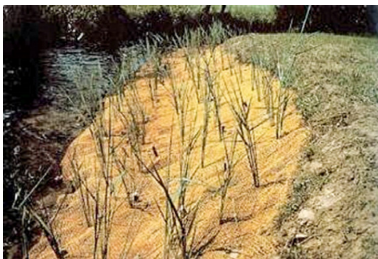
Fot. 71. Umocnienie z siatki jutowej z sitowiem i sadzonkami pędowymi [Begemann i Schiechl 1999]
