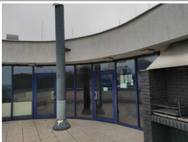
Fot.3: Widoczne ślady zawilgocenia i odspojenia tynku na attyce płyty stropodachu i odspojenia tynku na murku płyty tarasu od strony zewnętrznej
