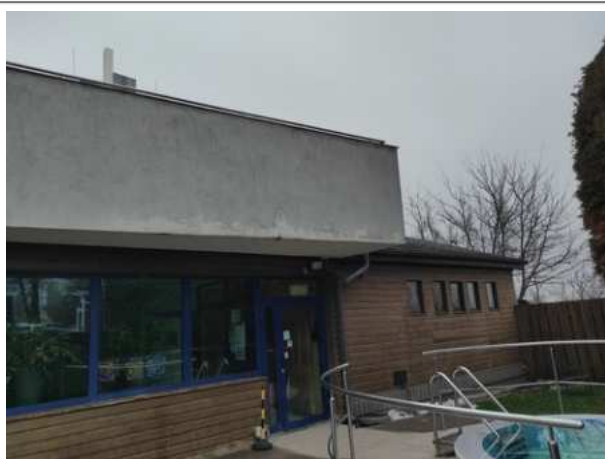
Fot.3: Widoczne ślady zawilgocenia i odspojenia tynku na attyce płyty stropodachu i odspojenia tynku na murku płyty tarasu od strony zewnętrznej
