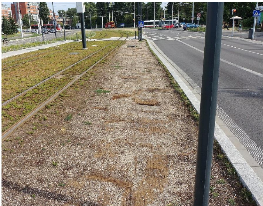
Obrázok 1 Stav rozchodníka v mieste chýbajúceho chodníka
