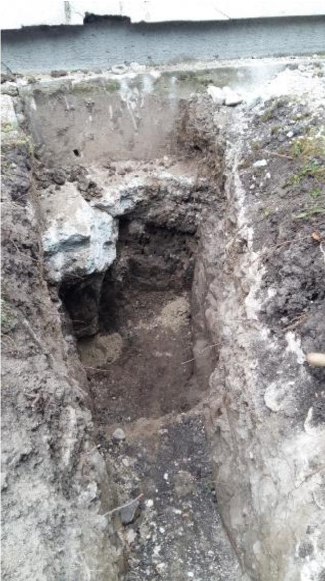
Kopaná sonda so základovou pätkou na lôžku štrkopiesku
