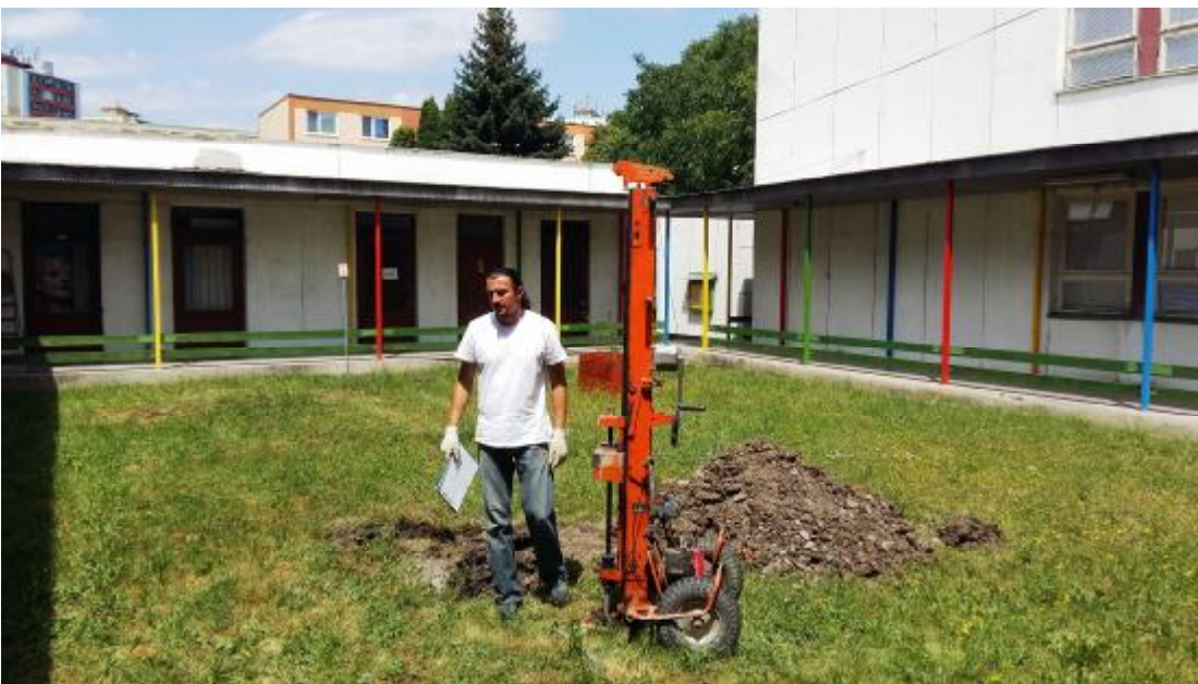
Vykonávanie dynamických penetračných skúšok
