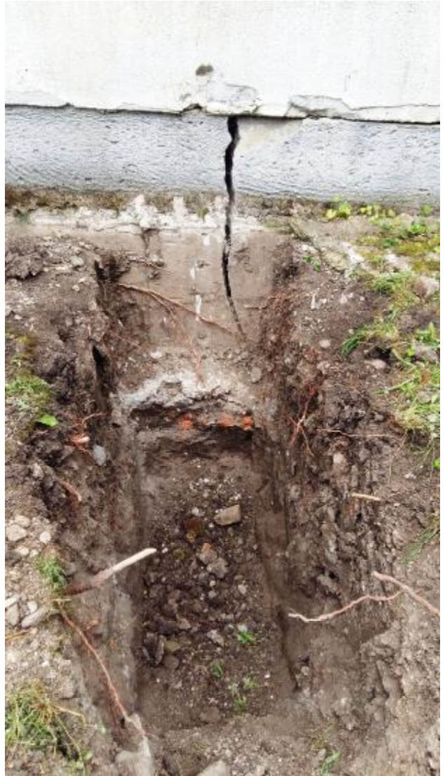
Kopaná sonda so základovým pásom so základovou škárou ešte v navážkach
