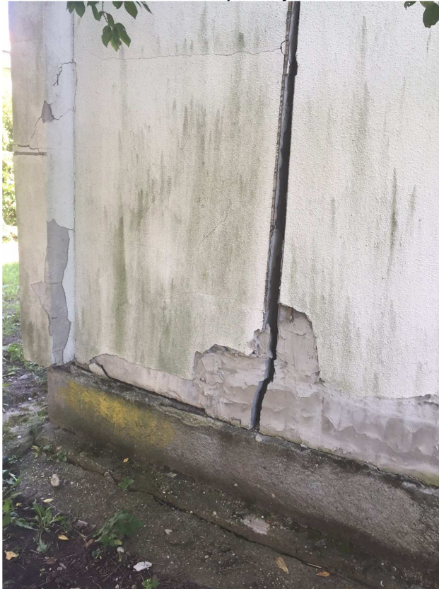
Poškodené obvodové panely
