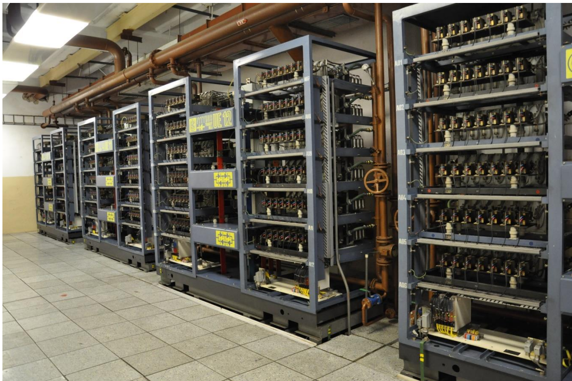
Obr. 2 - Meničová zostava (pohľad na sieťový aj motorový menič ES1)
