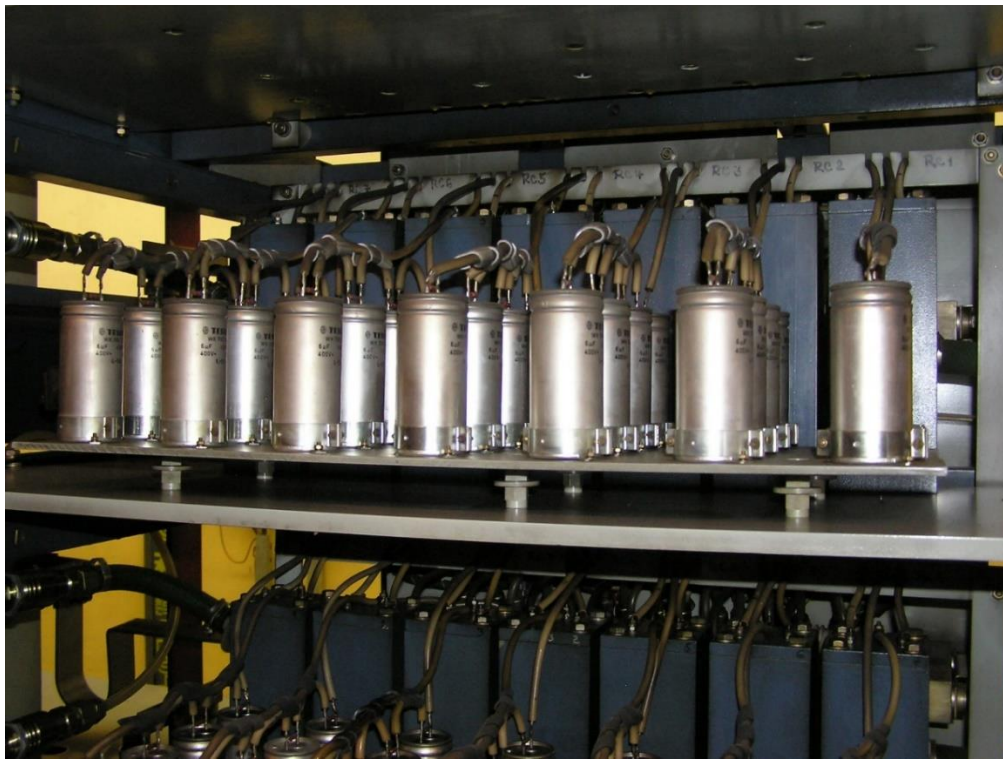
Obr. 6 - Olejové kondenzátory RC členov
