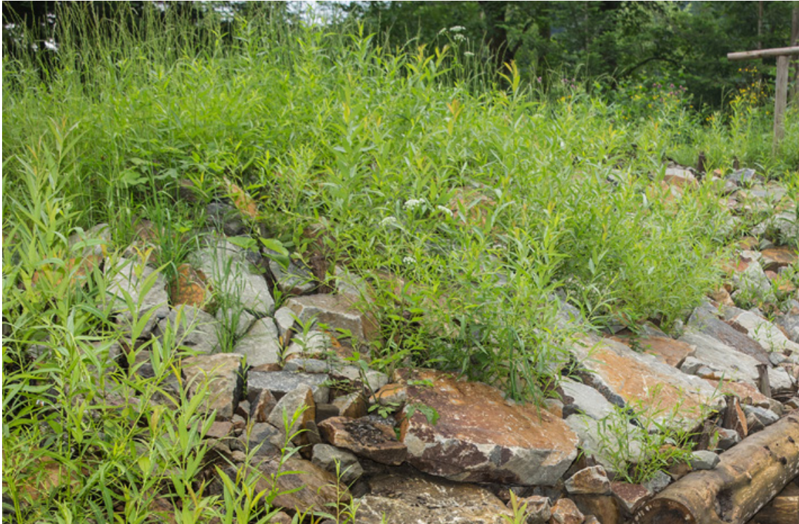
Fot. 2. Koryto ciekumocnione ożywionym narzutem kamiennym, Nadleśnictwo Baligród, 2021 (fot. J. Smarczewski)
