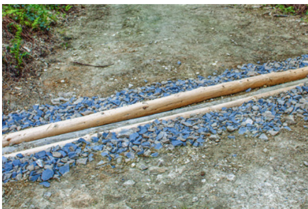
Fot. 106. Wodospust z okrągłaków w Nadleśnictwie Gorlice, 2015 (archiwum CKPŚ)
