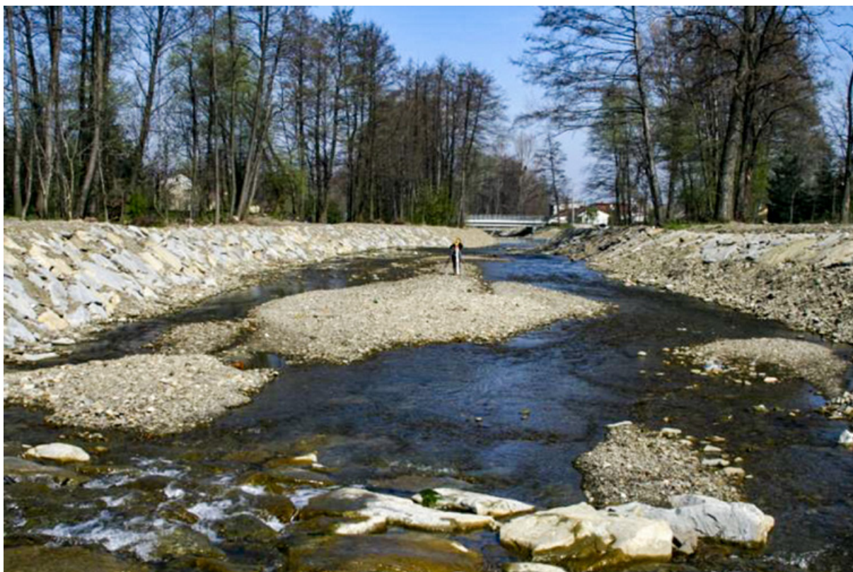
Fot. 1. Odtwarzająca się łacha korytowa po wykonaniu bystrza o zwiększonej szorstkości, Targaniczanka, 2009 (fot. L. Książek)
