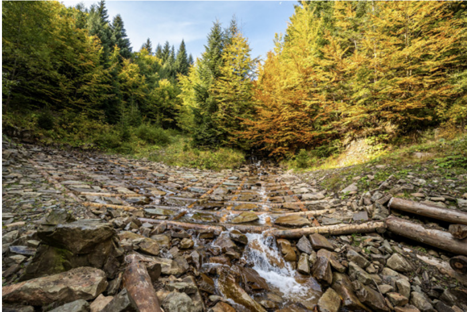
Fot. 125. Bród drewniano-kamienny koncentrujący wodę pośrodku, Nadleśnictwo Jeleśnia (fot. J. Smarczewski, 2021)
