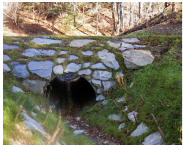
Fot. 97. Przepust umocniony kamieniem łamanym z nasadzeniami w korycie w Nadleśnictwie Komańcza [ https://komancza.krosno.lasy.gov.pl/projekty-i-fundusze ]
