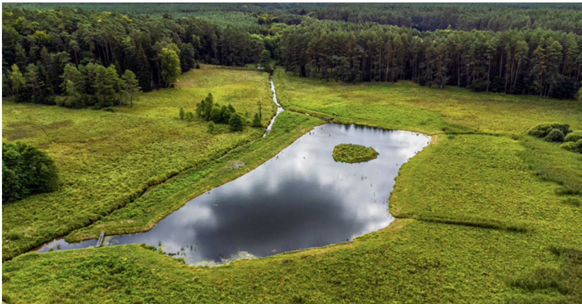
Fot. 17. Zbiornik boczny bez piętrzenia wody w korycie ciek naturalnego w Nadleśnictwie Jastrowie (fot. J. Smarczewski, 2021)
