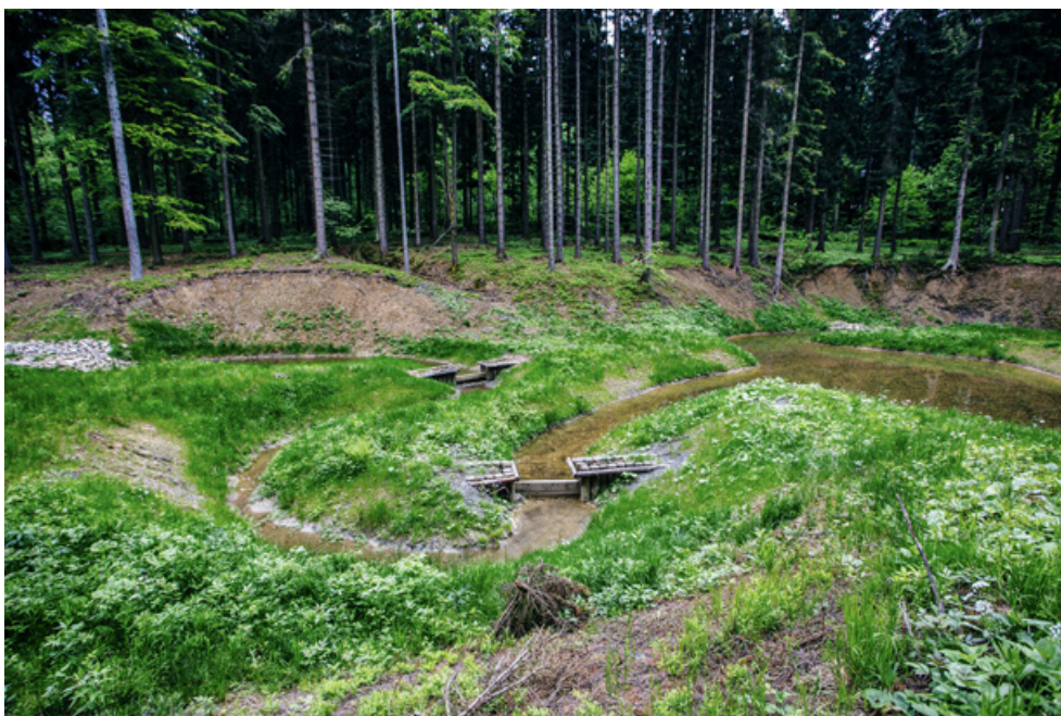
Fot. 131. Zatoka zastoiskowa/mikrozbiornik i zastawki na dopływie, Nadleśnictwo Międzyzlesie (archiwum CKPŚ)
