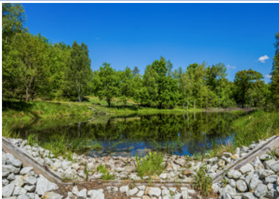
Fot. 44. Próg drewniany z umocnieniem kamiennym w Nadleśnictwie Okonek (fot. J. Smarczewski, 2023)
