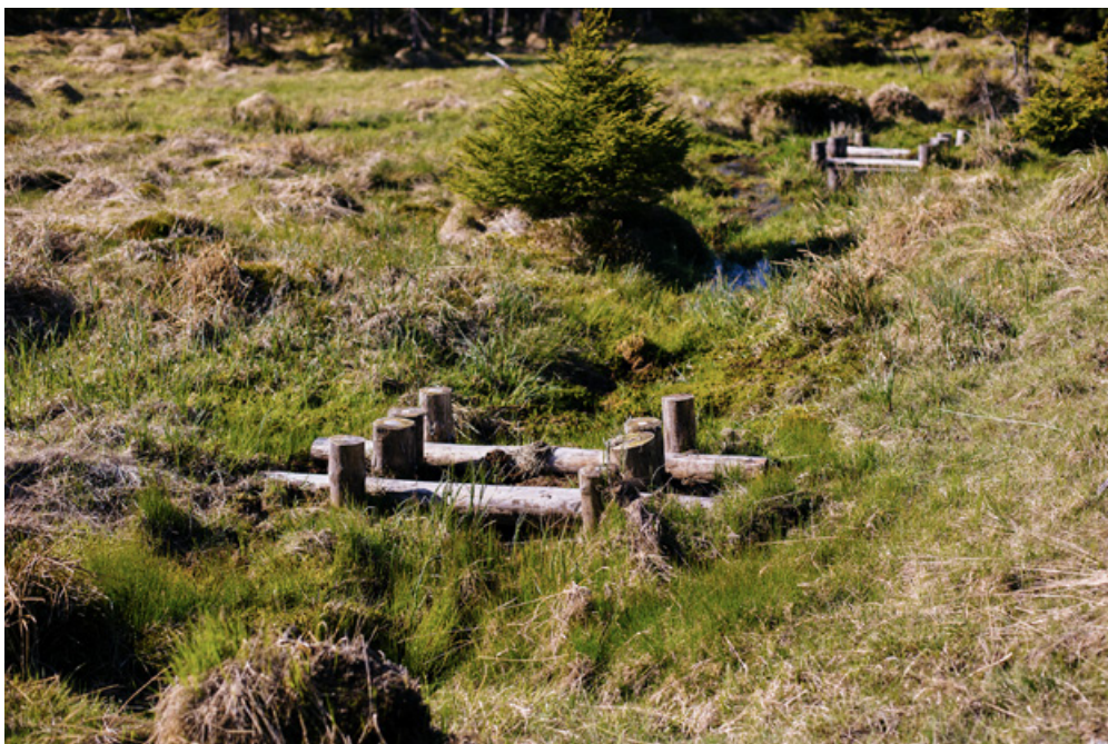
Fot. 39. Zarastający rów odwadniający dzięki zastosowaniu przetamowań ziemno-drewnianych w Nadleśnictwie Szklarska Poręba, 2015 (archiwum CKPŚ)
