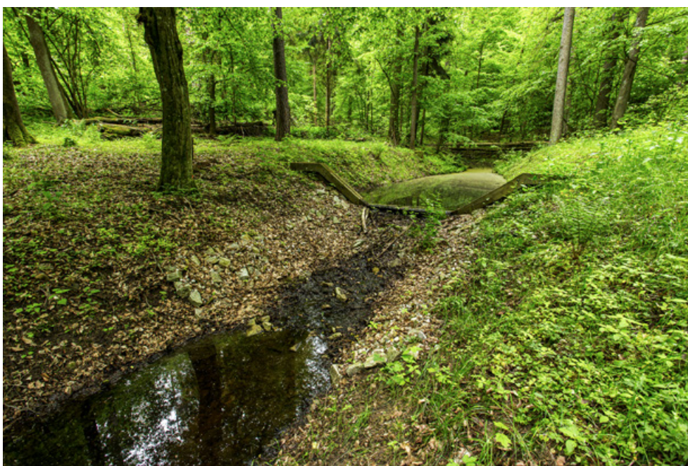
Fot. 38. Piętrzenie stałe – ścianka szczelna podparta bystrzem w Nadleśnictwie Maskulińskie, 2015 (archiwum CKPŚ)
