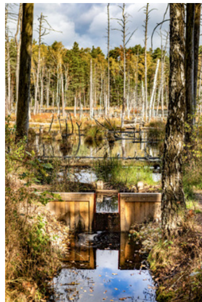
Fot. 33. i Fot. 34. Zastawki drewniane w Nadleśnictwie Celestynów (fot. J. Smarczewski, 2021)
