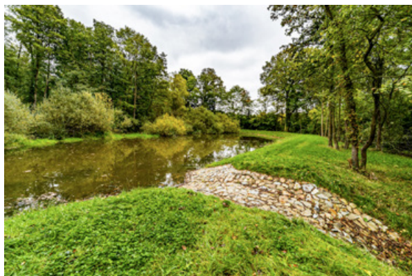
Fot. 28. Przelew górny w zbiorniku w Nadleśnictwie Oborniki Śląskie (fot. J. Smarczewski, 2021)
