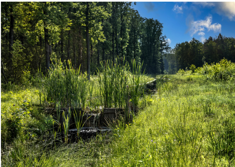
Fot. 40. Próg drewniany na rowie odprowadzającym wodę wkomponowany w otoczenie przez zarastającą roślinność, Nadleśnictwo Sokółów Podlaski (archiwum CKPŚ)
