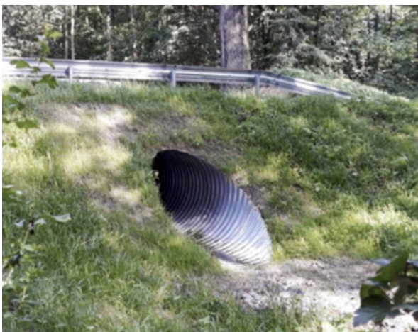
Fot. 96. Przepust ze ściętym rurociągiem i pochyłym przyczółkiem niewymagający umocnień technicznych w Nadleśnictwie Tułowice [ https://tulowice.katowice.lasy.gov.pl/mrn2 ]
