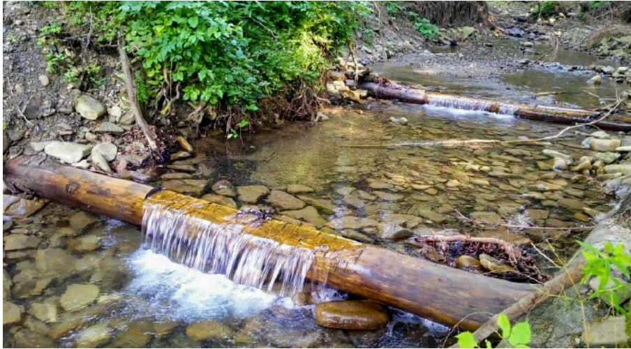
Fot. 42. Próg drewniany z przelewem z okrągłaków (fot. I. Biedroń [Biedroń 2018])
