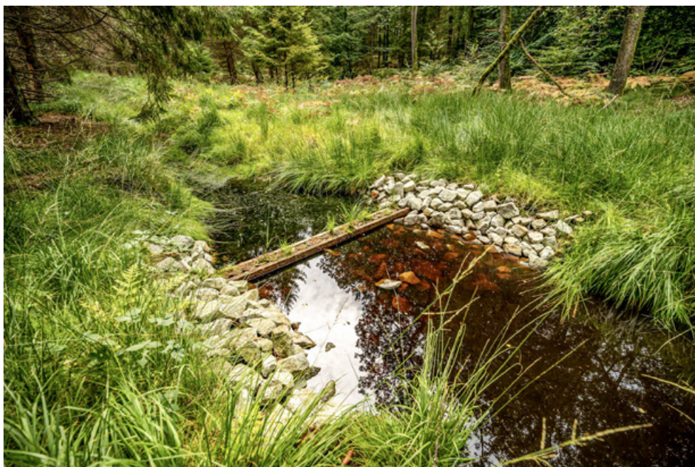
Fot. 43. Próg ze ścianki szczelnej w Nadleśnictwie Polanów (fot. J. Smarczewski, 2021)
