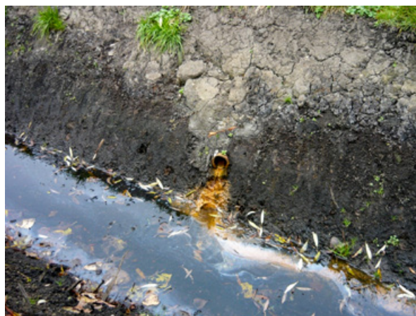
Fot. 52. i Fot. 53. Przypadkowo odkryty wylot drenarski/rurociąg drenarski na terenie gruntów należących do Przedsiębiorstwa Rolno-Przemysłowego „Agromax”, powiat raciborski (fot. Ł. Borek)
