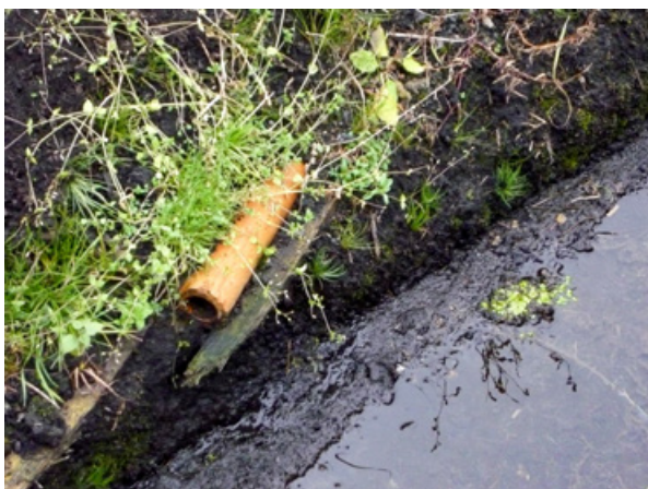
Fot. 52. i Fot. 53. Przypadkowo odkryty wylot drenarski/rurociąg drenarski na terenie gruntów należących do Przedsiębiorstwa Rolno-Przemysłowego „Agromax”, powiat raciborski (fot. Ł. Borek)
