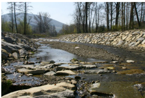
Fot. 74. Narzut kamienny z dużych głazów układany mechanicznie, Targaniczanka (fot. L. Książek, 2009)
