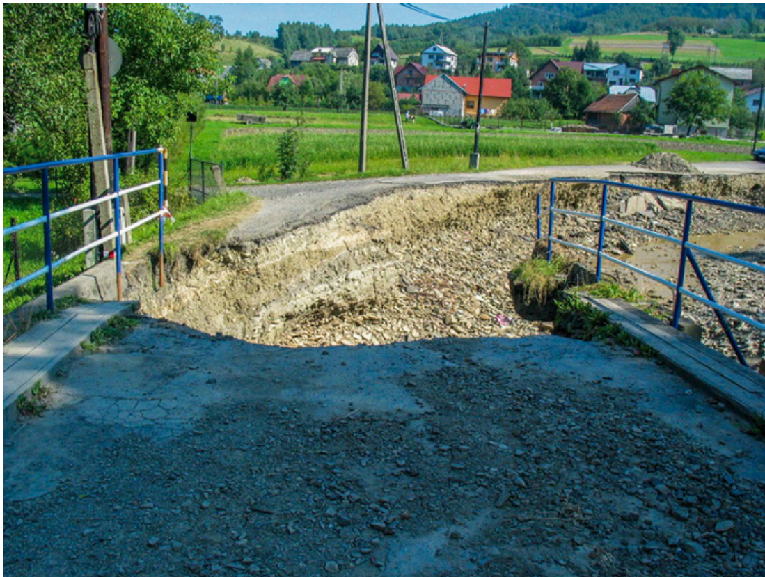
Fot. 146. Zerwany most, Targaniczanka (fot. L. Książek, 2005)
