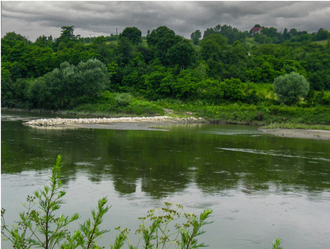
Fot. 4. Ochrona brzegów rzeki wyłącznie przez wykonanie głowic ostróg, Wisła (fot. L. Książek, 2005)
