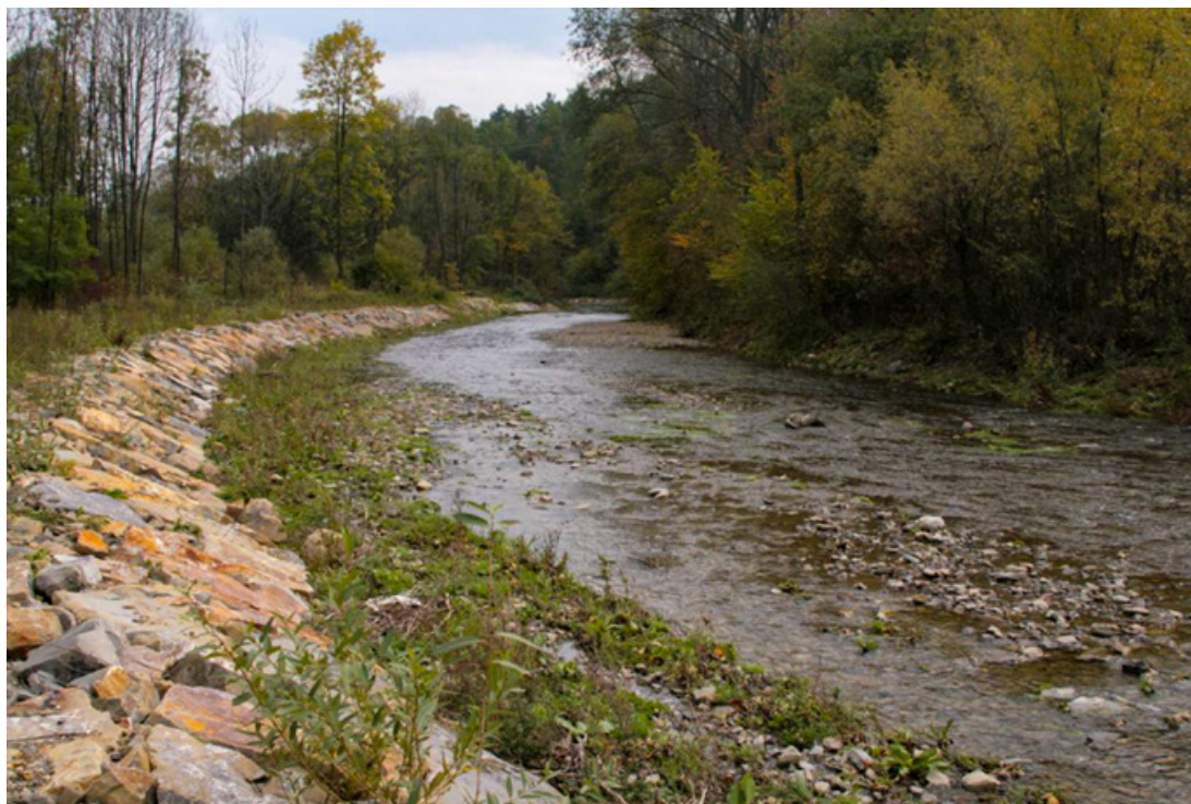
Fot. 87. Zabezpieczenie brzegu wklęsłego narzutem kamiennym (fot. L. Książek, 2007)
