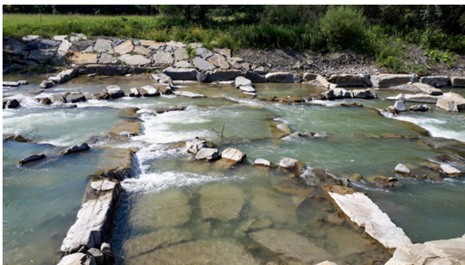
Fot. 99. Bystrze kaskadowe typu „plaster miodu”, rzeka Biała Tarnowska w rejonie miejscowości Florynka (fot. L. Książek, 2020)
