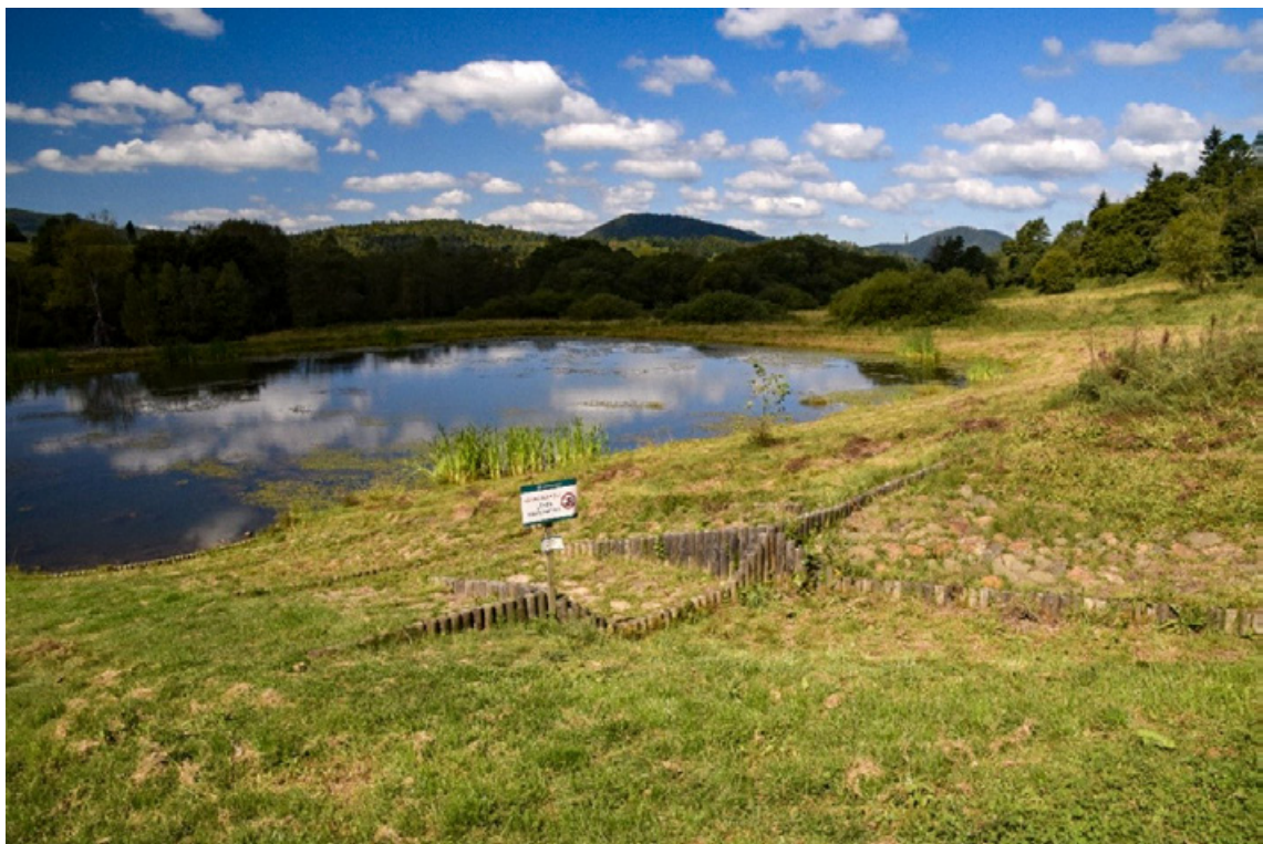
Fot. 119. Końcowy zbiornik w układzie kaskadowym w Nadleśnictwie Baligród zasilany z cieką, a dodatkowo także wodą doprowadzoną z rowu przydrożnego – na pierwszym planie widoczne miejsce zasilania zbiornika wodą z rowu (fot. M. Mikulska)
