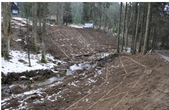
Fot. 78. Kratownica drewniana pełniąca funkcję ubezpieczenia skarpy, Nadleśnictwo Międzylesie (archiwum CKPŚ)
