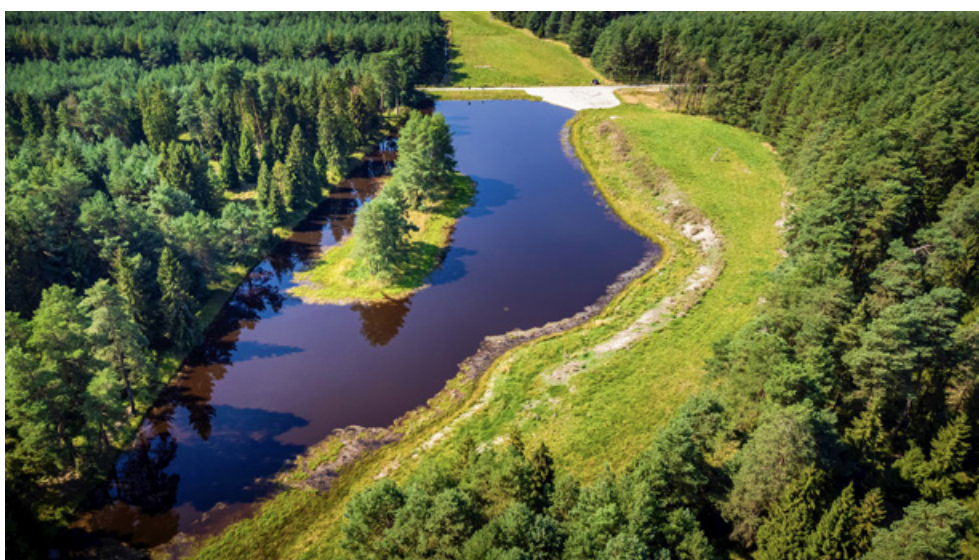
Fot. 16. Zbiornik zaporowy w Nadleśnictwie Brynek (fot. J. Smarczewski, 2021)
