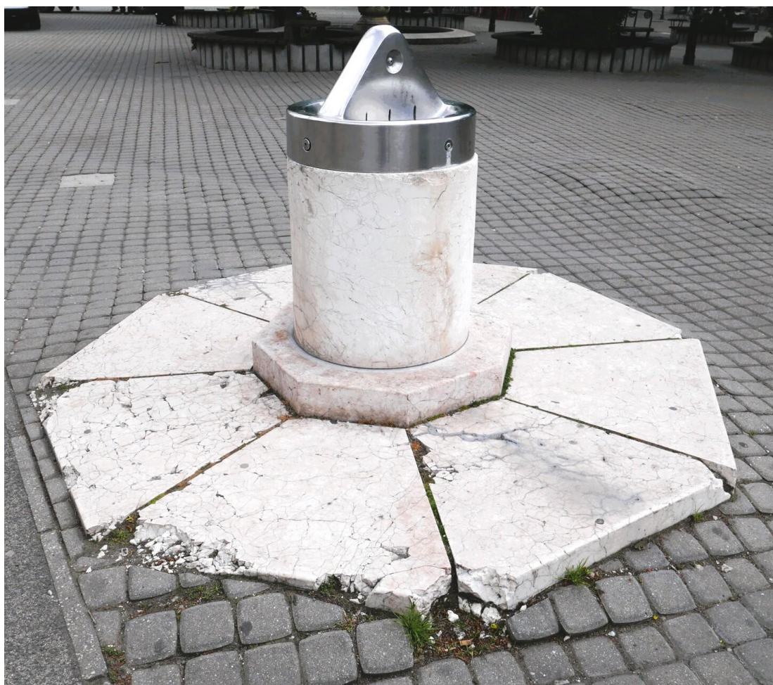
Pitná fontánka na Námestí Nežnej revolúcie – celkový pohľad a detail
