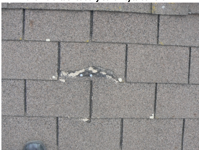
F11 Detail poškodenej časti šindlovej krytiny strechy južnej telocvične
