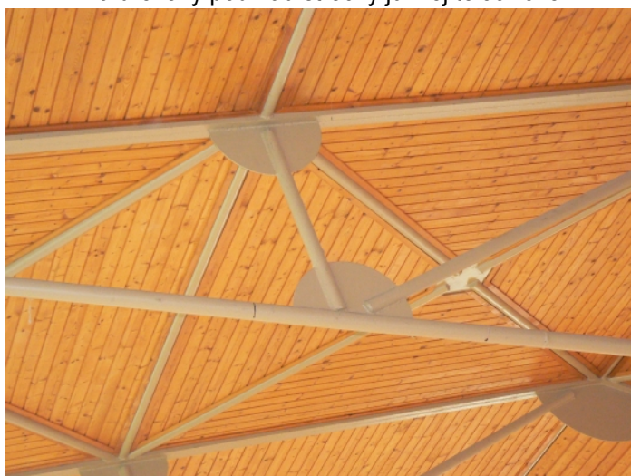
F18 Detail oceľových strešných väzníkov a ich zavetrenie v strede strešnej roviny strechy južnej telocvične
