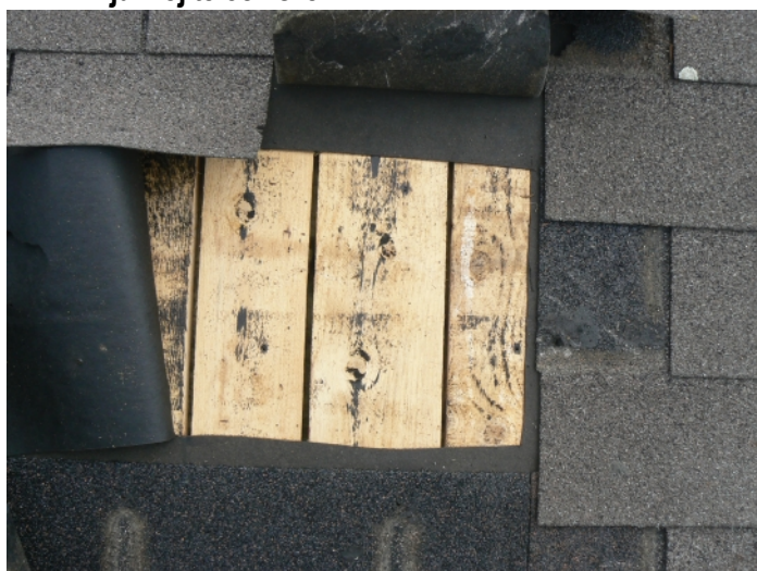
F12 Detail horného doskového záklopu strechy južnej telocvične tesne pod jej šindlovou strešnou krytinou
