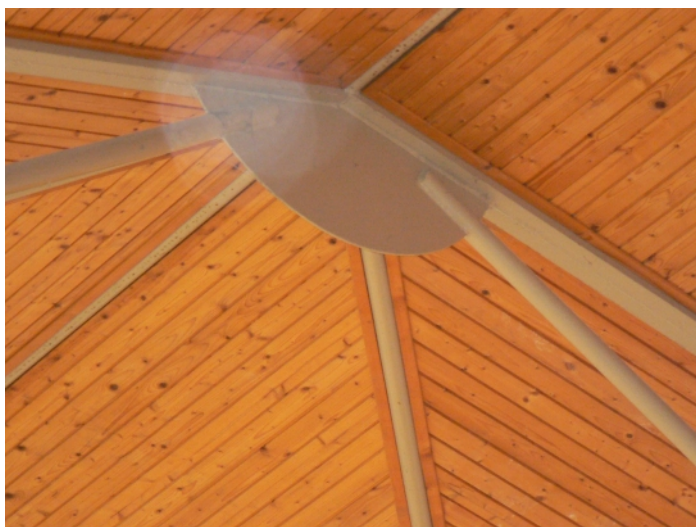
F19 Detail oceľových strešných väzníkov a ich zavetrenie v hrebeni strechy južnej telocvične
