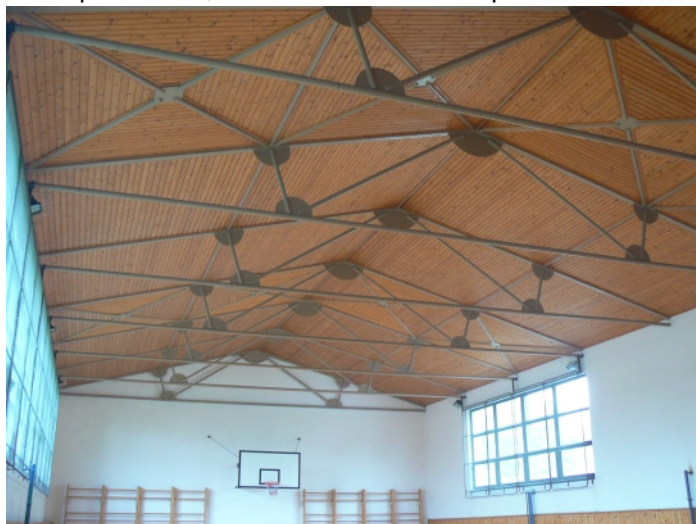
F16 Celkový pohľad na oceľovú nosnú konštrukciu a drevený podhľad strechy južnej telocvične
