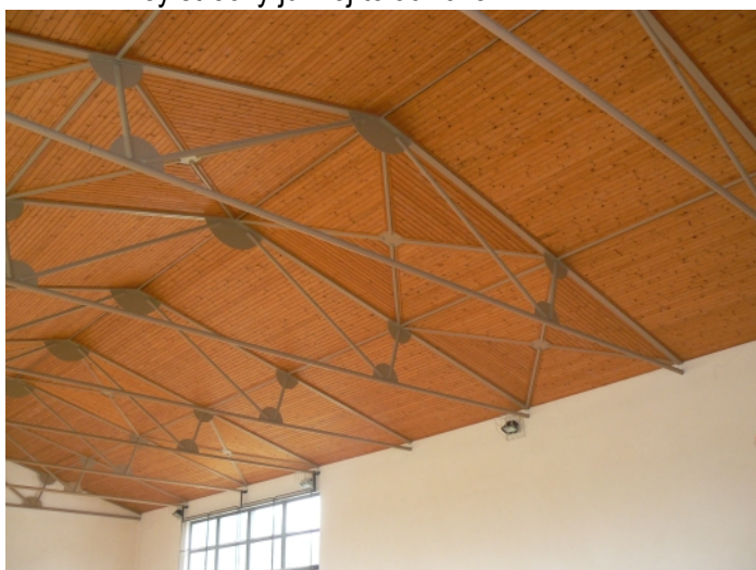
F17 Pohľad na oceľovú nosnú konštrukciu a podhľad strechy južnej telocvične v mieste jej zavetrovania
