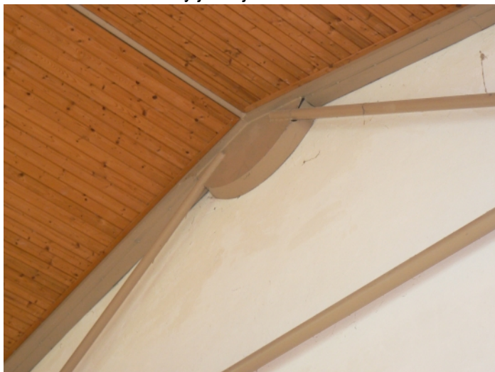
F21 Detail krajného priehradového strešného väzník pri štítovej stene v hrebeni strechy
