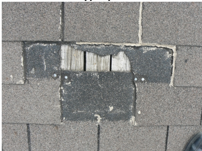
F10 Detail poškodenej časti šindlovej krytiny strechy južnej telocvične
