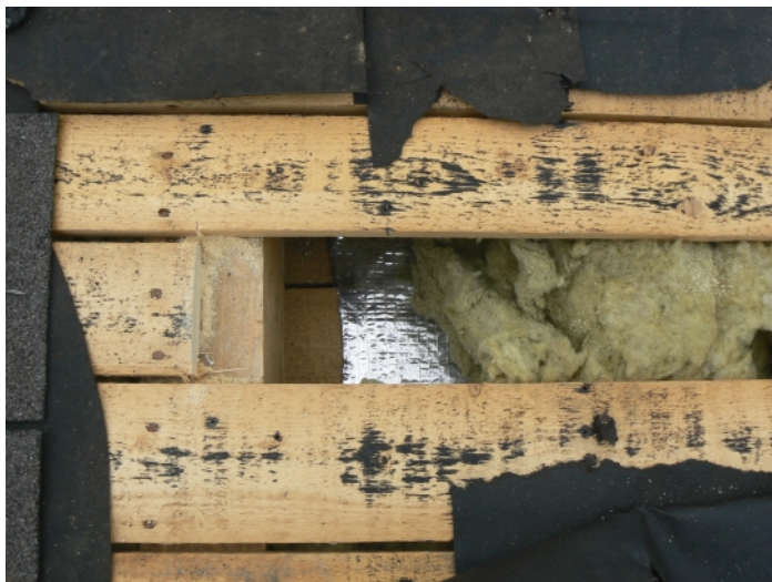
F13 Detail prieskumnej sondy v streche južnej telocvične s nefunkčne uloženou parozábranou
