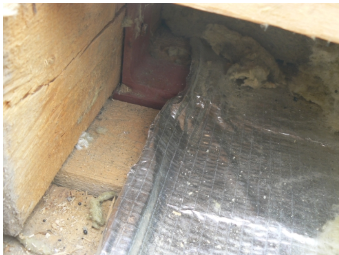
F14 Detail prieskumnej sondy v streche južnej telocvične pri väzníku, s nefunkčne uloženou parozábranou
