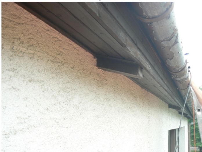
F15 Detail konštrukčného riešenia existujúcej strešnej rímky strechy južnej telocvične
