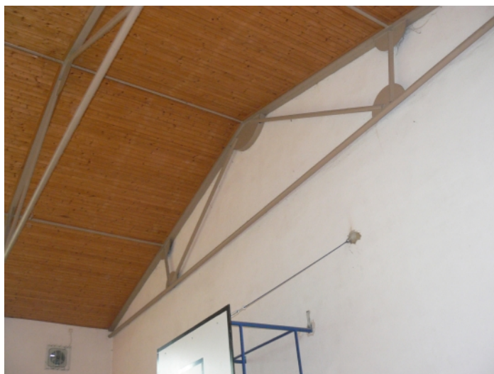
F20 Celkový pohľad na krajný priehradový strešný väzník pri štítovej stene strechy južnej telocvične
