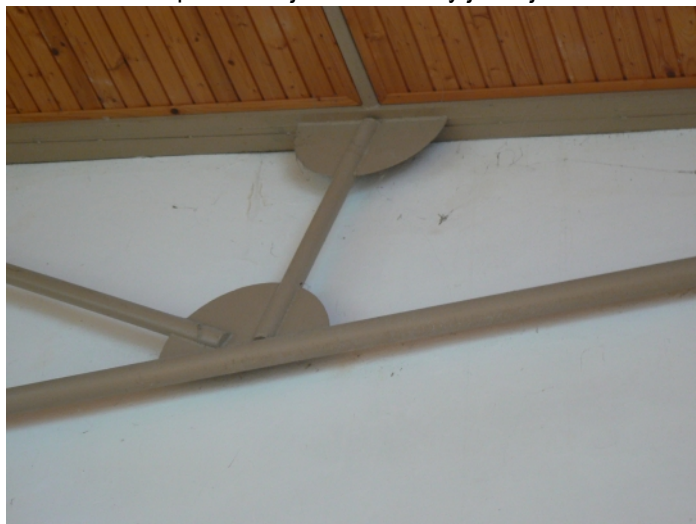
F22 Detail krajného priehradového strešného väzník pri štítovej stene v jeho strede
