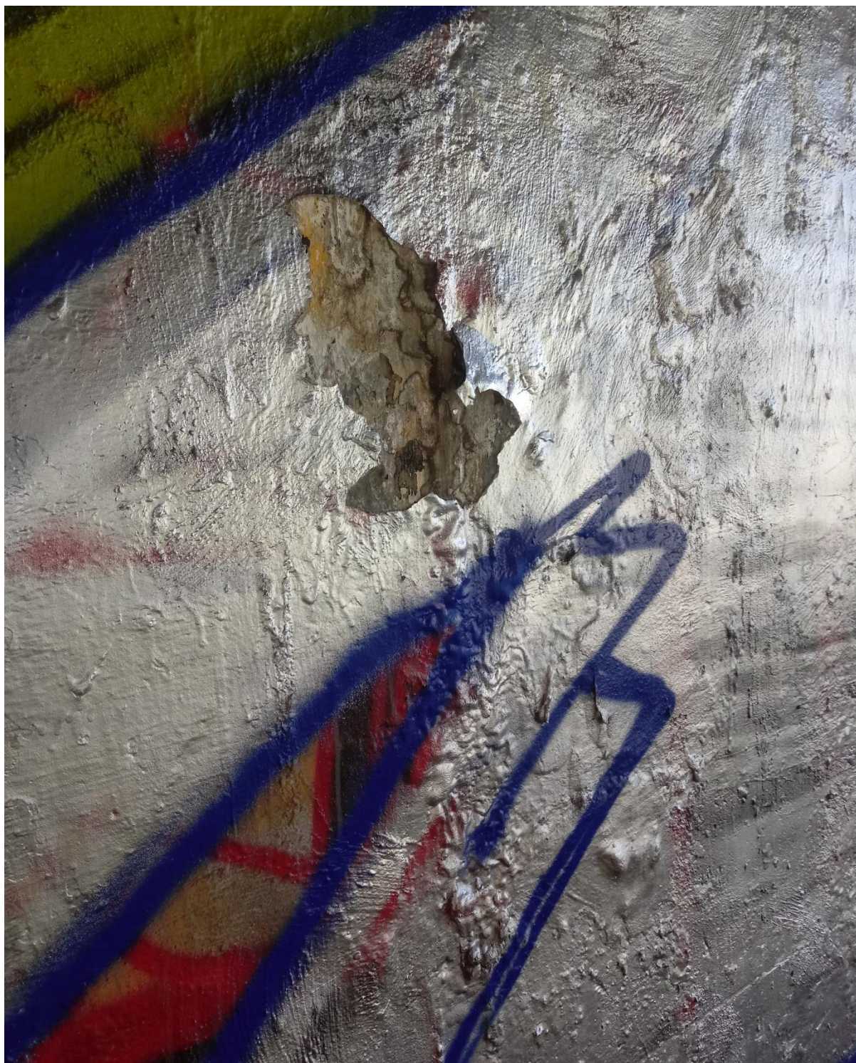
Obr. 8 Olúpaný a vydutý náter opory
