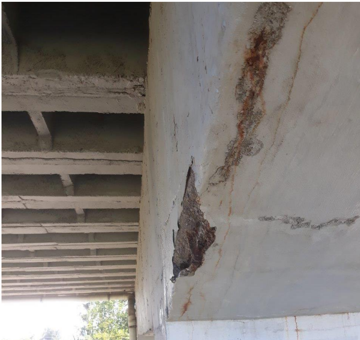
Obr. 12 Skorodovaná výstuž na konzole úložného prahu podpory č.2
