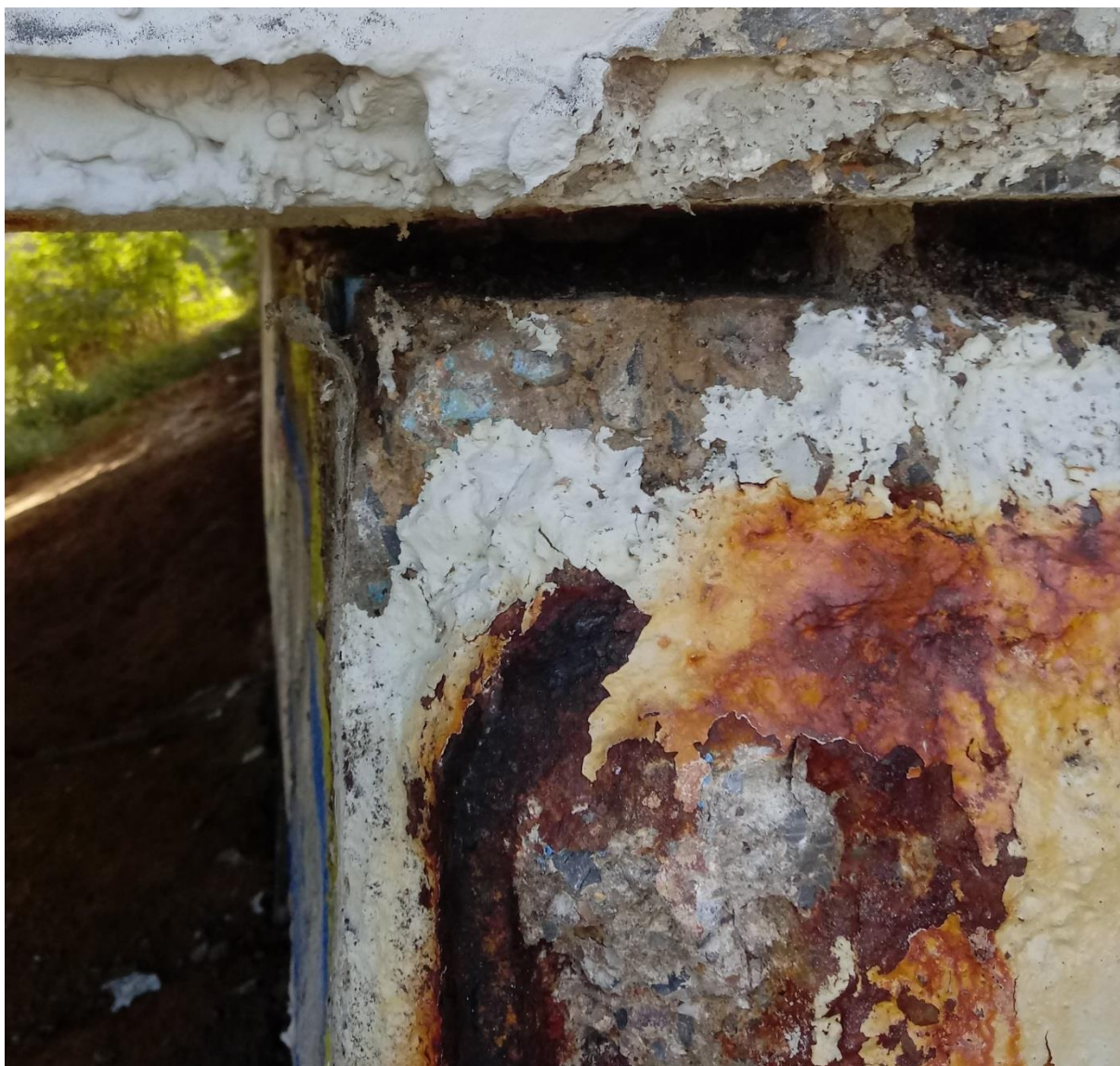
Obr. 7 Obnažená skorodovaná výstuž na opore
