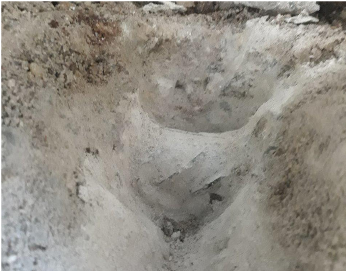
Obr. 11 Detail hlavnej výstuže úložného prahu, výstuž \Phi 32
