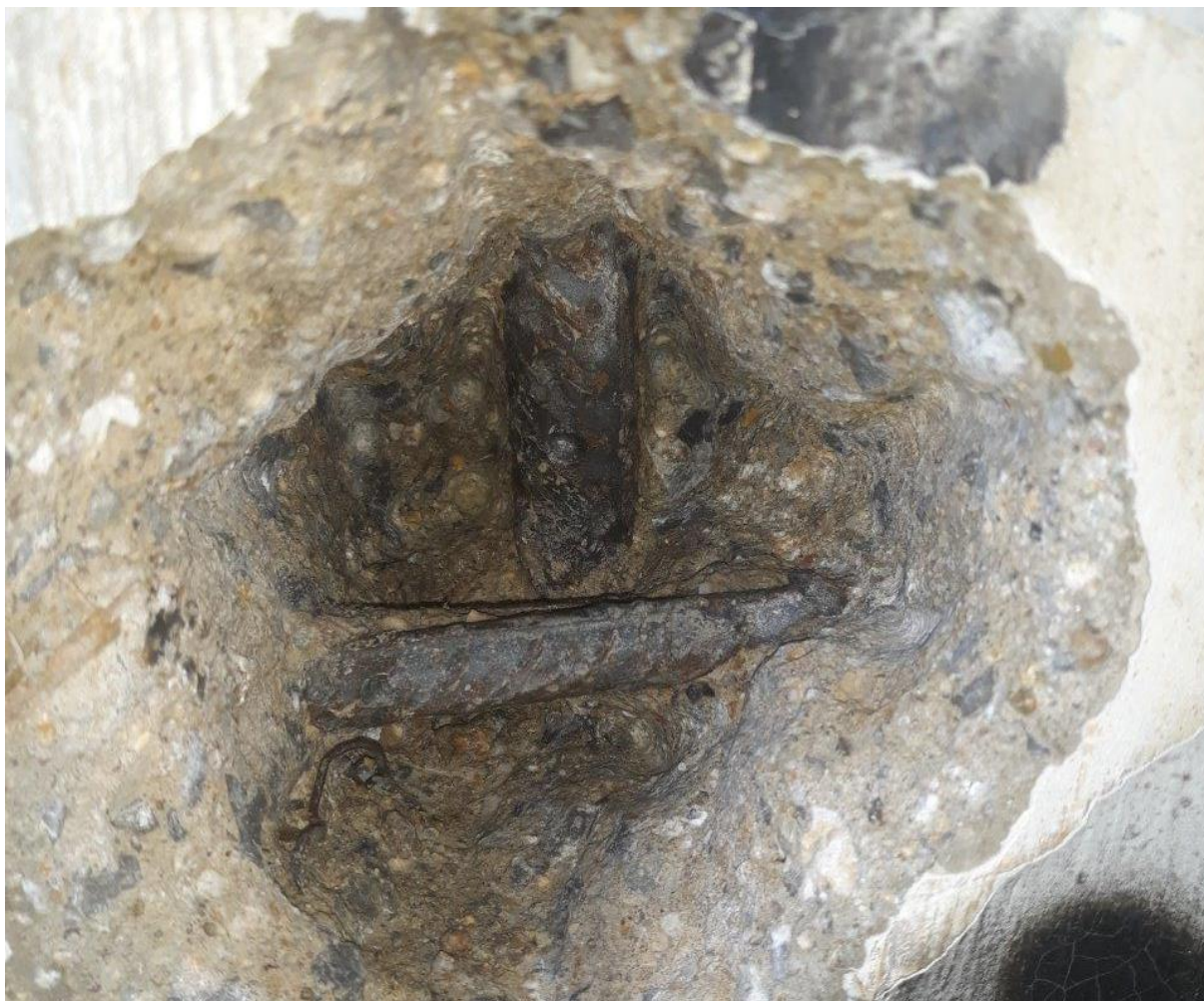
Obr. 10 Vodorovná a zvislá výstuž stĺpa podpery
