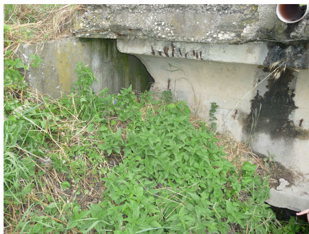
Obr. Obnažené kotevné hlavy predpínacej výstuže, nosná konštrukcia bez koncových monolitických priečnikov, zasypanie nk
