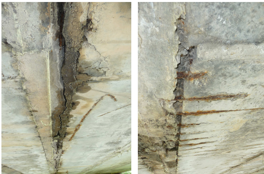
Obr. Porušenie priečneho spojenia nosníkov, zatekanie do NK
