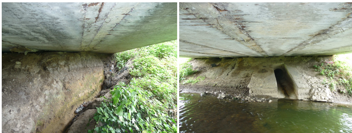
Obr. Vymieľanie terénu pri opore1, nespevnený terén pri opore 1 a opore 2
