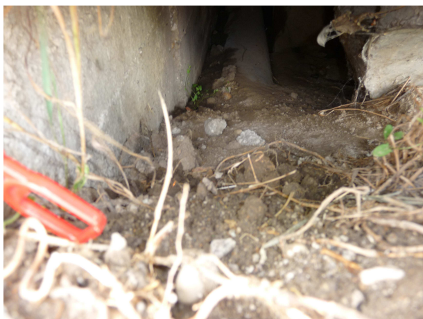
Obr. Zasypanie dilatačnej škáry medzi nk a oporou 2
