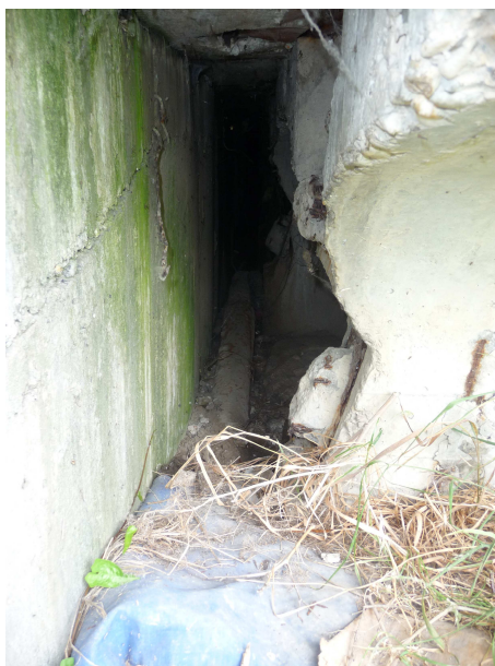
Obr. Obnažené kotevné hlavy predpínacej výstuže, nosná konštrukcia bez koncových monolitických priečnikov, zasypanie nk
