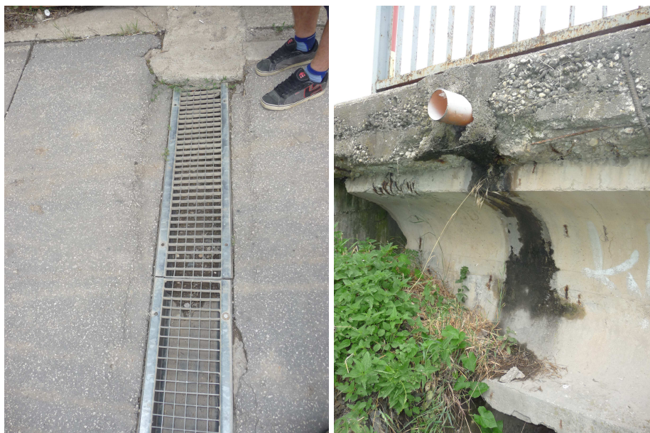
Obr. Odvodňovací žlab v rímsovej časti s vyústením cez rímsu
