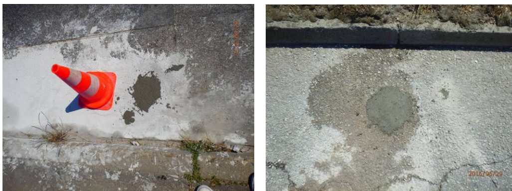
Obr. 3 Vypravenie vývrtov sanačnou zmesou
