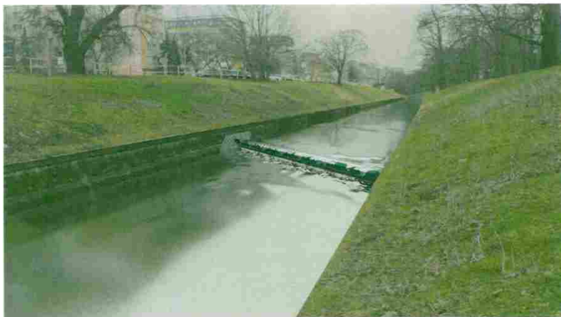
Obr. 34 Vaková haň umiestnená v relat. staničení 0,0005 km (pohľad proti prúdu)
