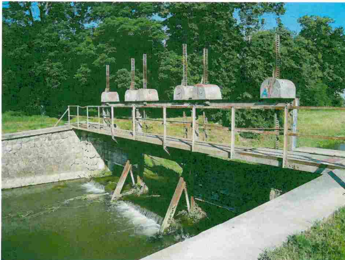
Obr. 1 Stavidlo na toku Trnávka, ktoré bolo v roku 2013 odstránené
