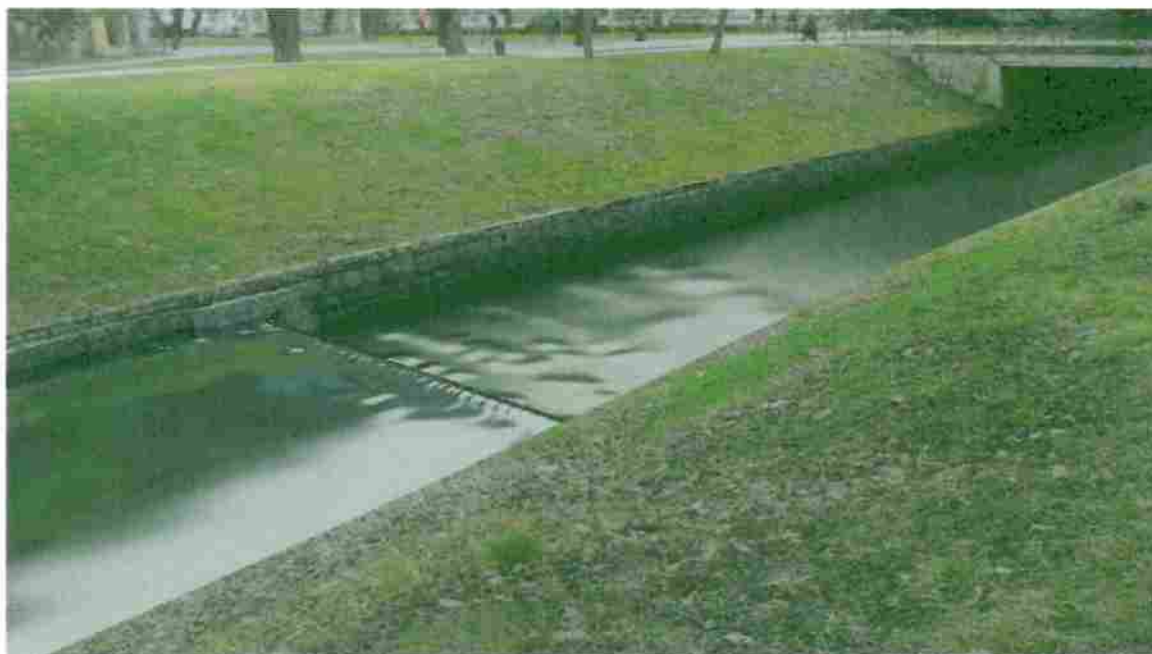
Obr. 36 Vaková hať umiestnená v relat. staničení 0,0005 km (pohľad po prúde)
