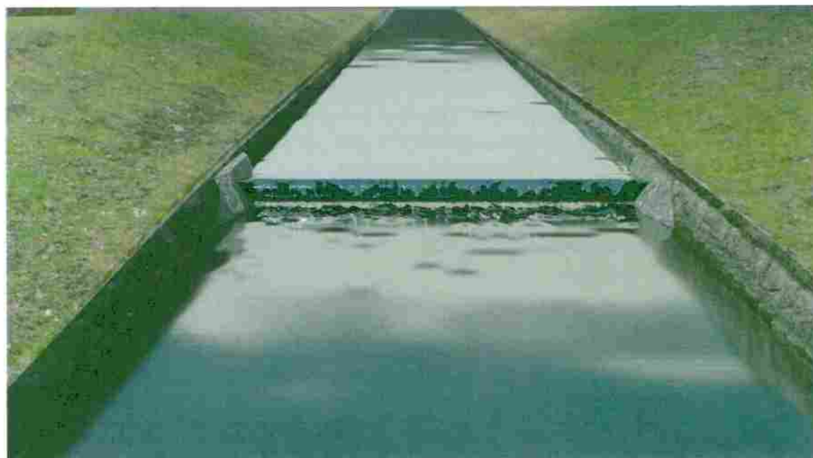
Obr. 35 Vaková haň umiestnená v relat. staničení 0,0005 km (pohľad z mosta)
