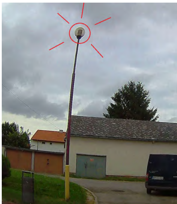
Obr. 18 Nevhodné umiestnenie svietidla na osvetlenie chodníka – Vnútrobloky
