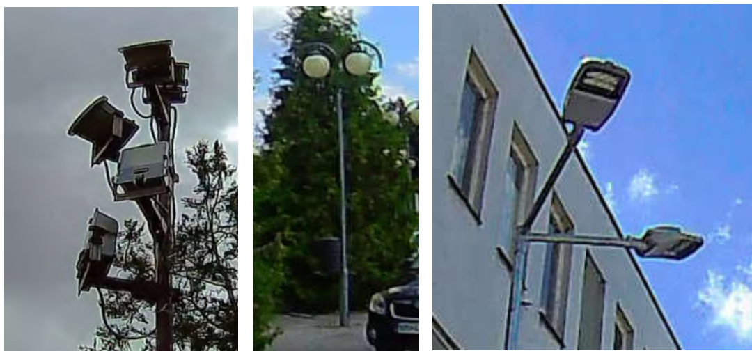
Obr. 5 Päť / dve svietidlá na oceľovom stožiar
