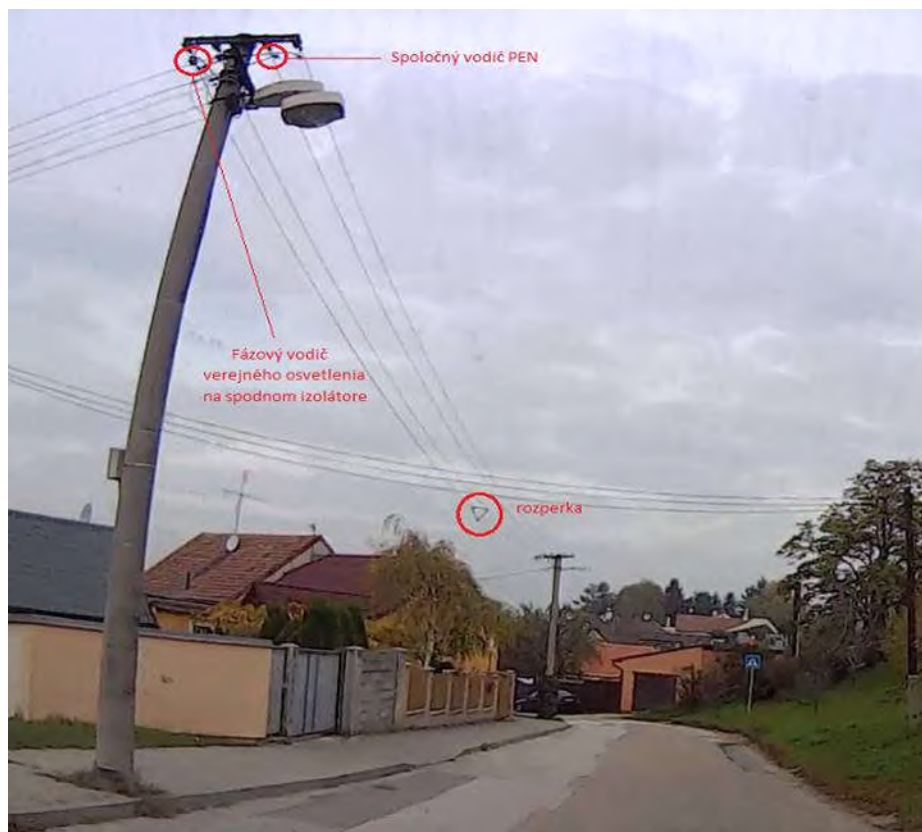
Obr. 14 Holé vzdušné vedenie typu AIFe 25
