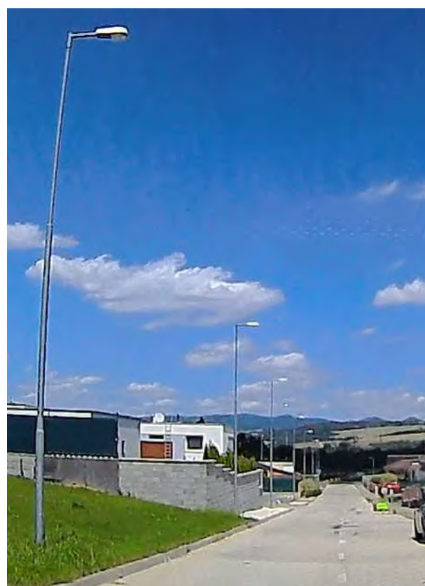
Obr. 13 Žiarovo zinkované stožiare na vo vedľajších a hlavných komunikáciách
