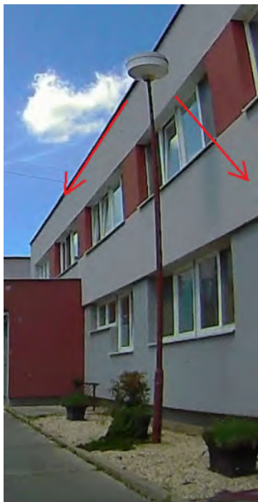
Obr. 18 Nevhodné umiestnenie svietidla na osvetlenie chodníka – Vnútrobloky
