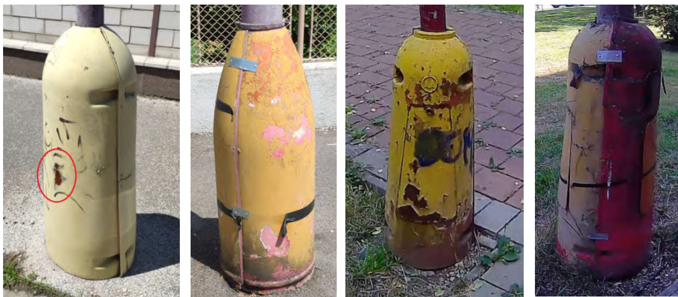
Obr. 10 Prepáskované, deravé, rozbyté, nezatesnené pätky stožiarov
