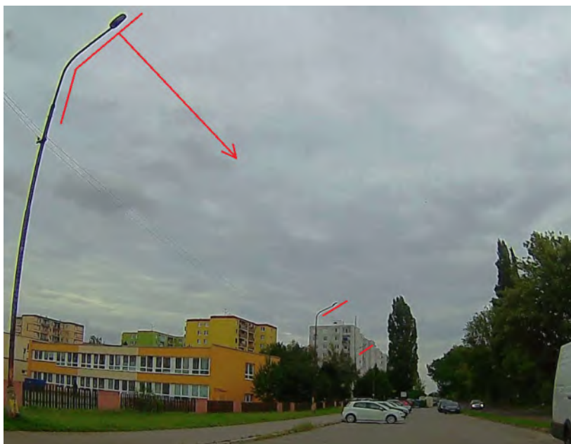
Obr. 16 Zlý uhol vyloženia
