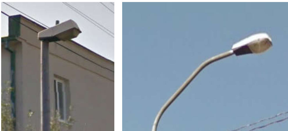
Obr. 1 Najrozšírenejšie svietidlá v sústave typu “BH” a “DI” znečistenie a korózia svietidla, materiálne opotrebovanie
