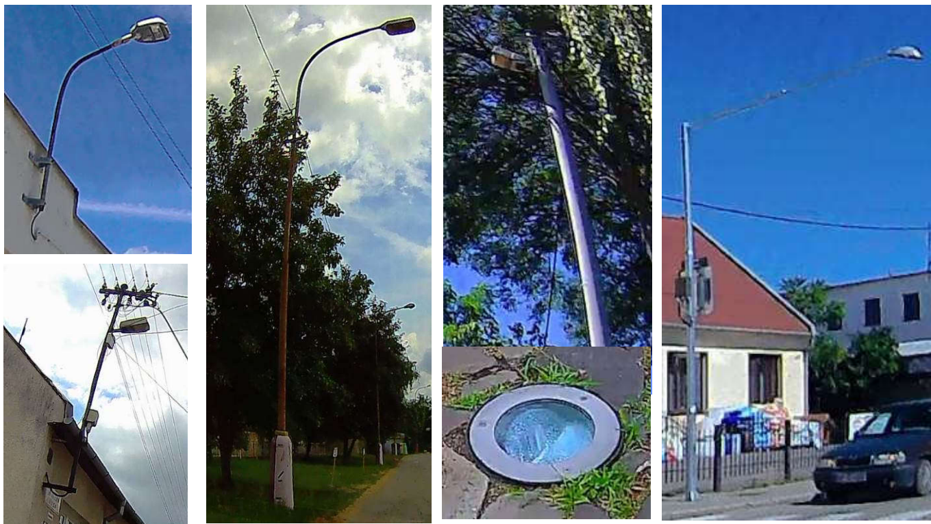
Obr. 4 Svietidlá na rôznych stožiaroch: oceľový stožiar – betónový stožiar – svietidlo na nástrešníku – svietidlo na fasáde – svietidlo na prechodovom stožiar
