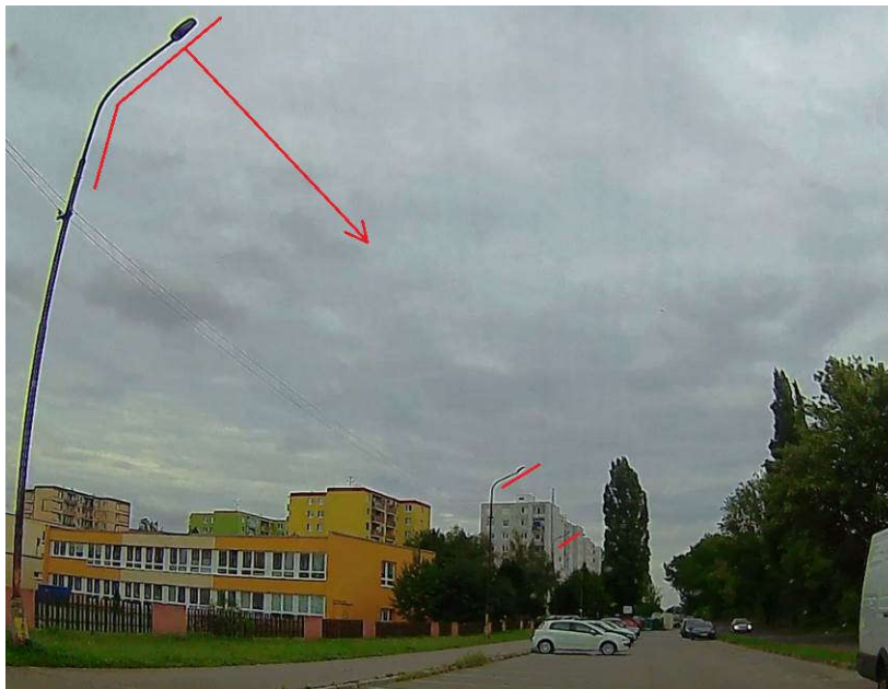
Obr. 16 Zlý uhol vyloženia
