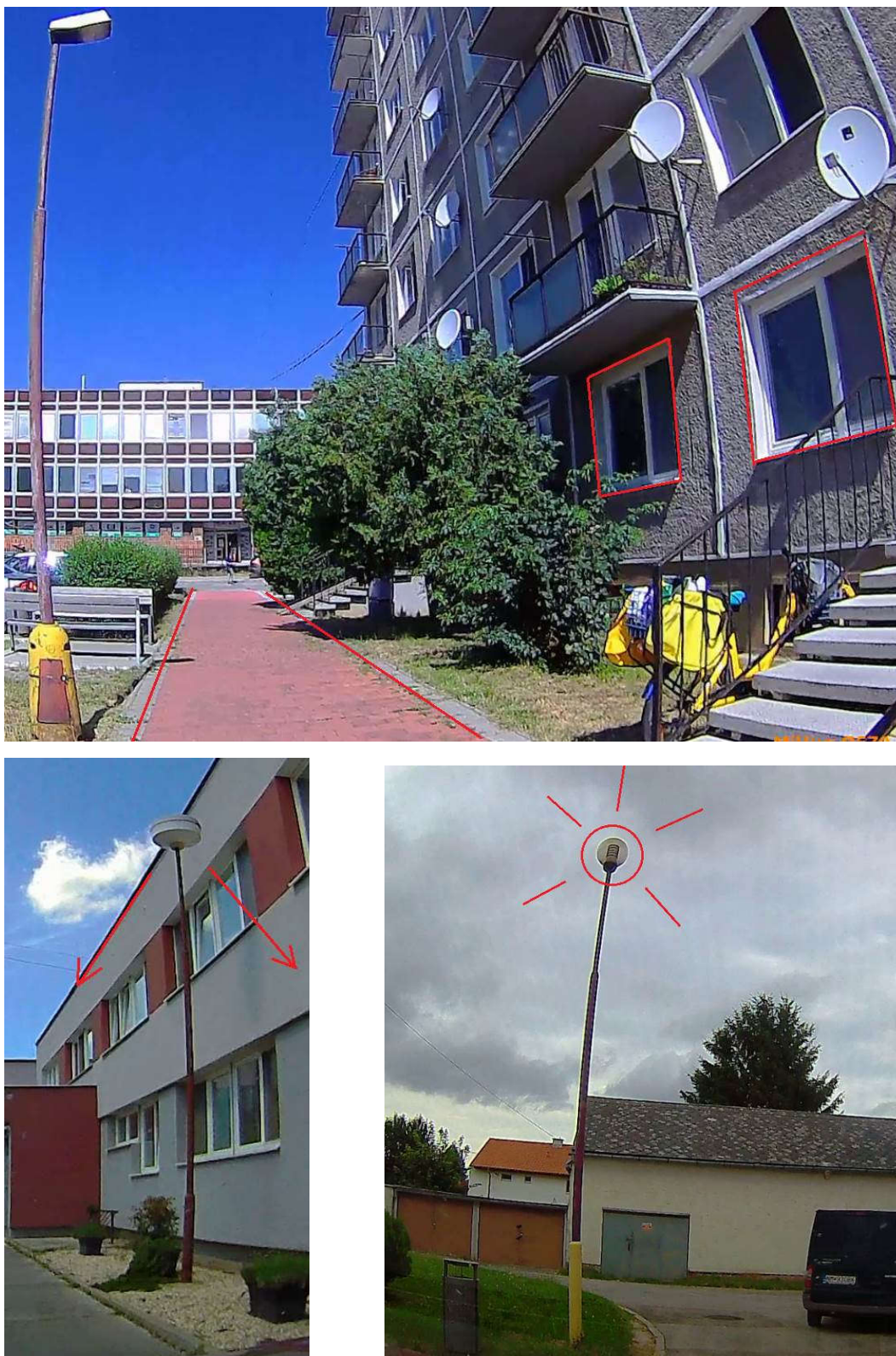
Obr. 18 Nevhodné umiestnenie svietidla na osvetlenie chodníka – Vnútrobloky
