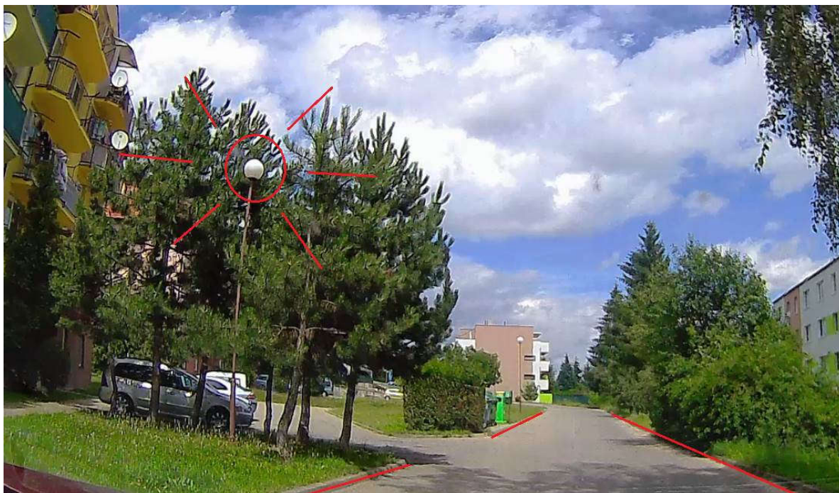
Obr. 19 Svietidlo typu „Globe“ – svietidlo nesvietí na miesto, kam by malo
