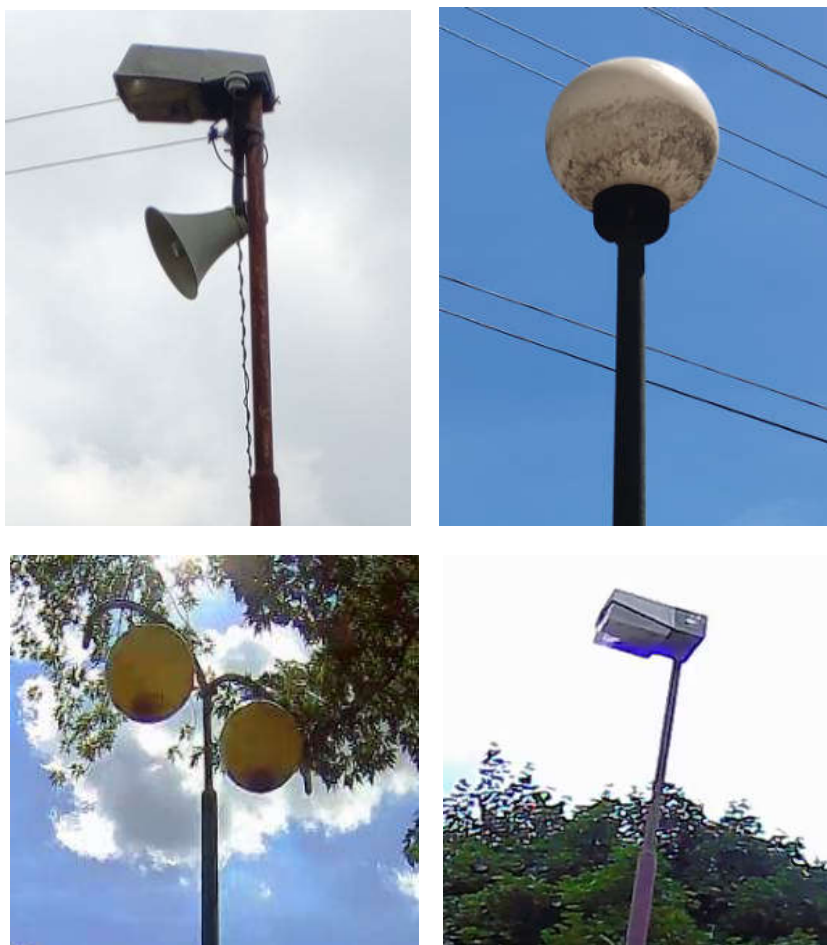
Obr. 2 Fyzicky opotrebované svietidlá typu “BH” / “Globe” / “KR”, prekročené hranice životnosti svietidiel
